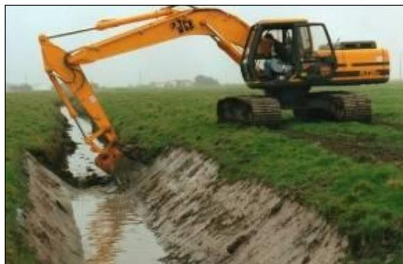
**Figure 1** : Exemples de curage et reprofilage de fossé
